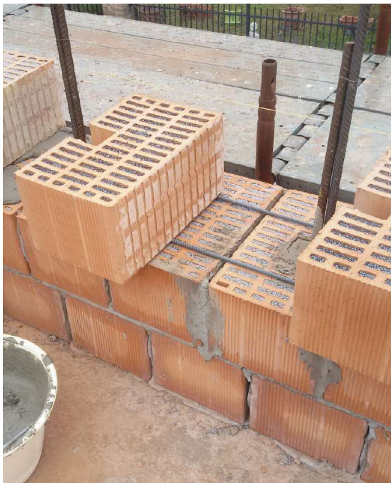
Particolare armatura orizzontale e verticale.
