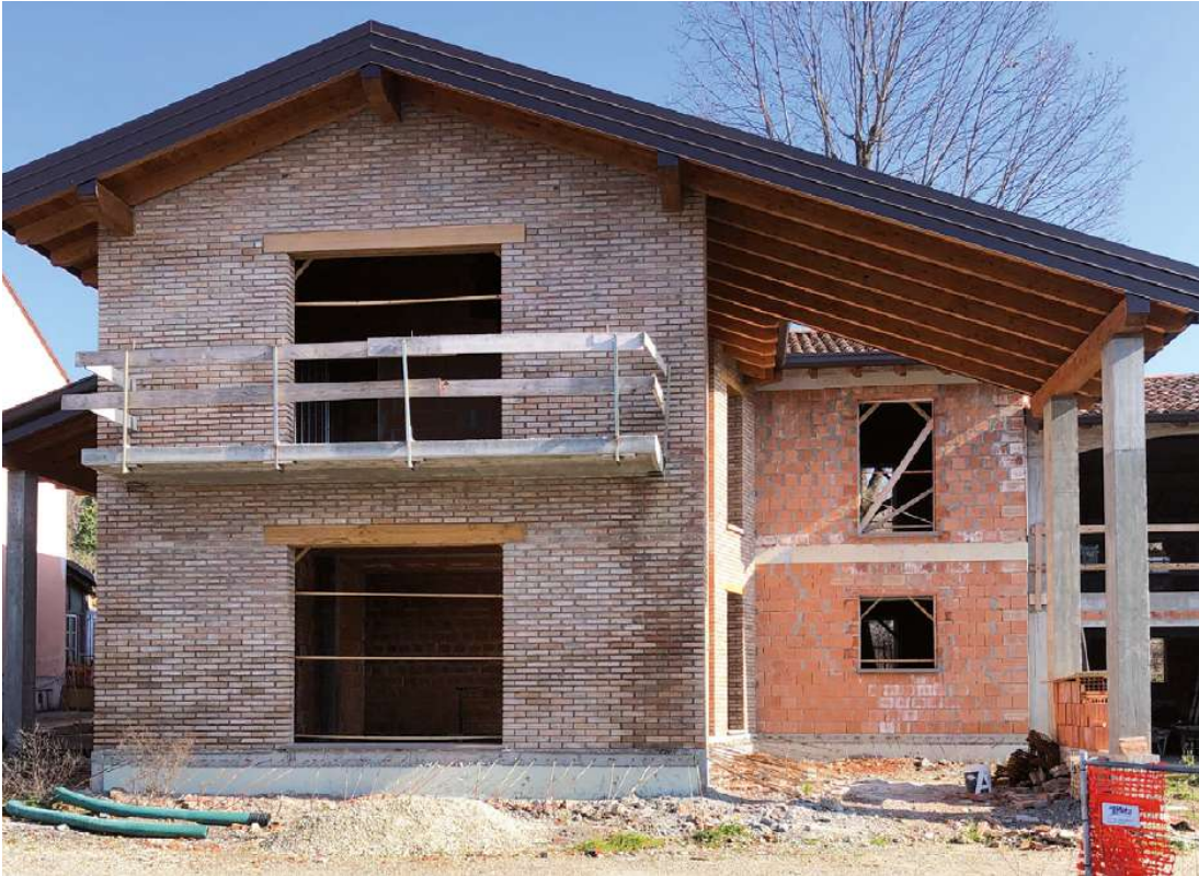
Stato avanzamento cantiere fronte principale.
