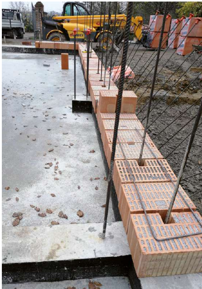
Spiccato di fondazione per la posa della muratura.
