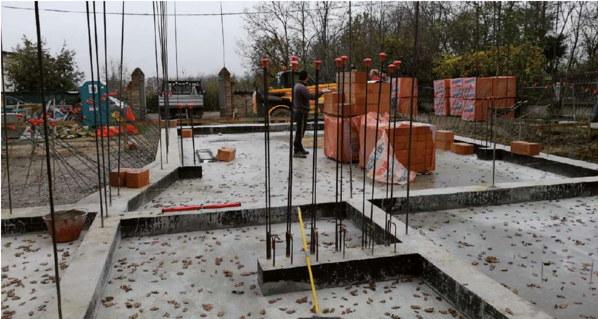
Spiccato di fondazione per la posa della muratura.
