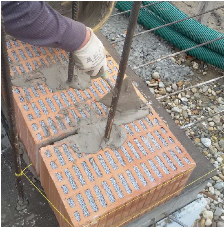
Posa del primo corso di blocchi della muratura armata.
