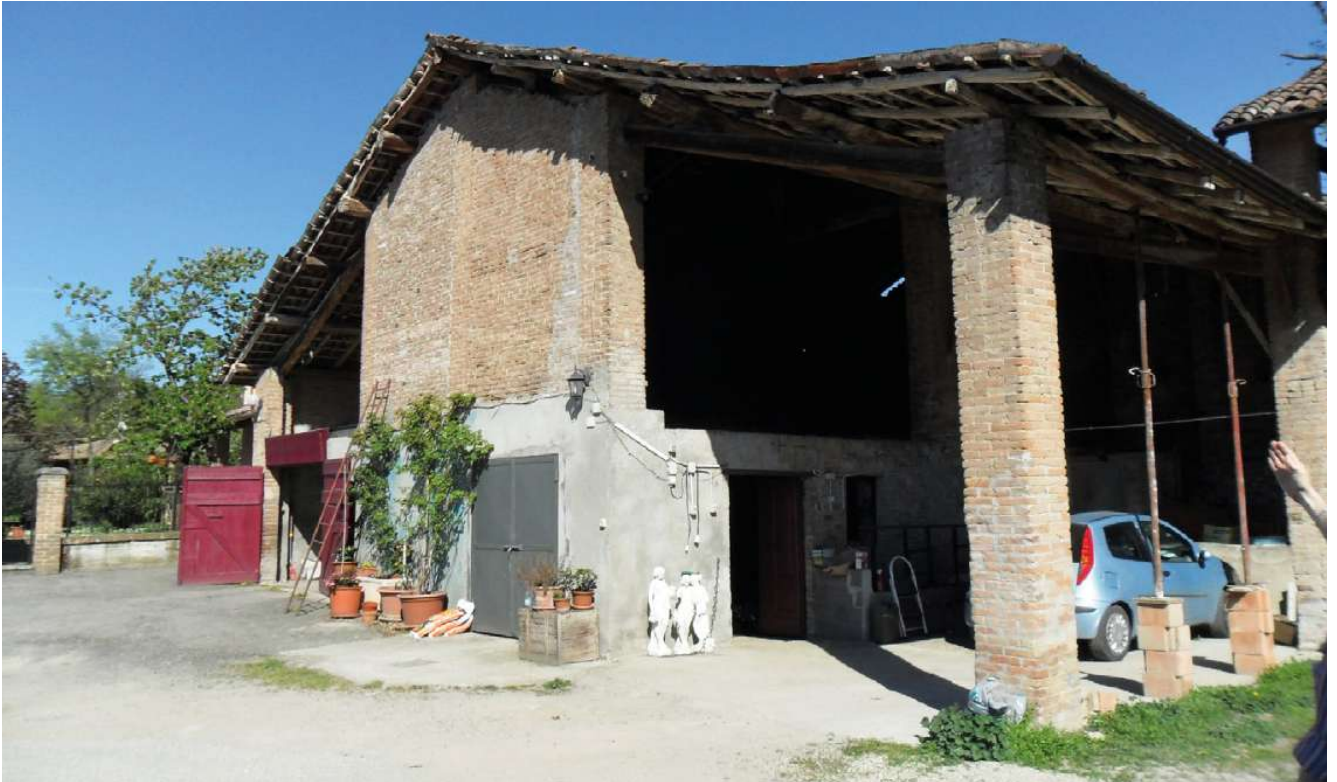
Stato di fatto della cascina ante opera.
