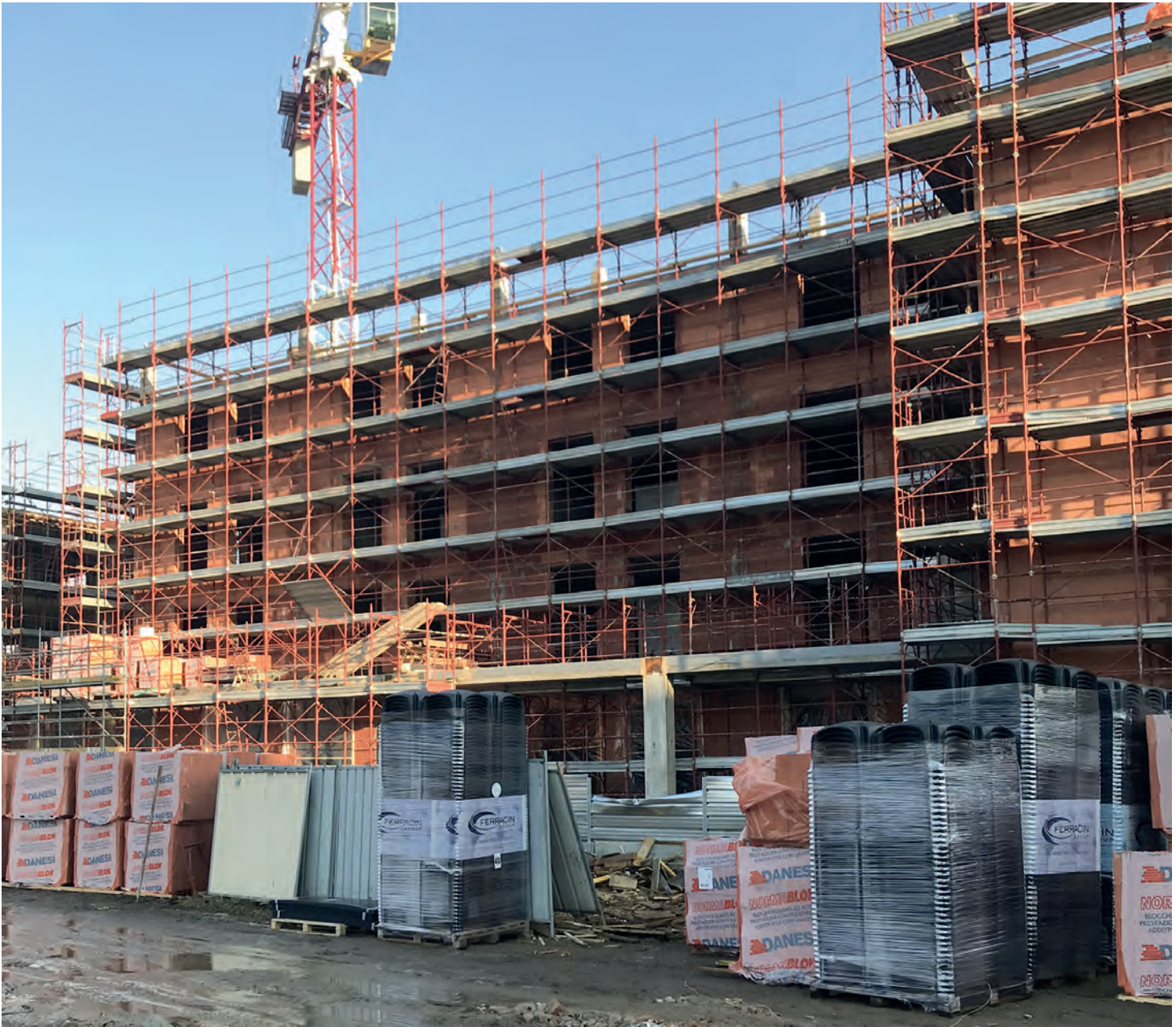
Il cantiere dell'edificio dell'APA.
