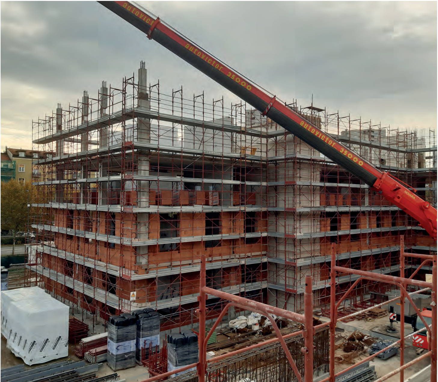
Il cantiere dell'edificio dell'RSA nella fase di completamento delle murature di tamponamento.
