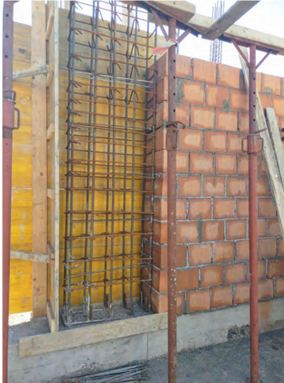
Collegamento pilastro-muratura armata.
