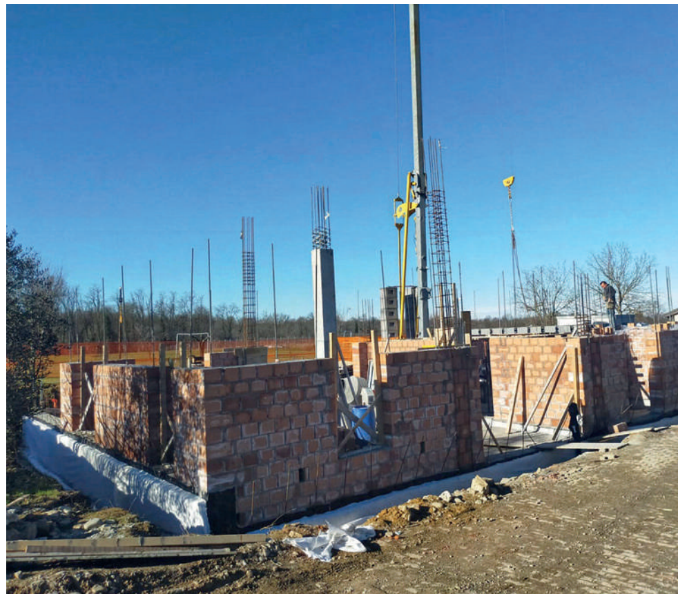
Muratura armata in costruzione.
