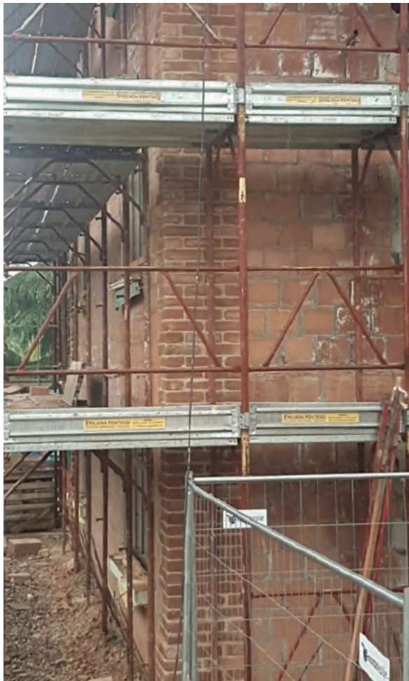
Dettagli di cantiere.
