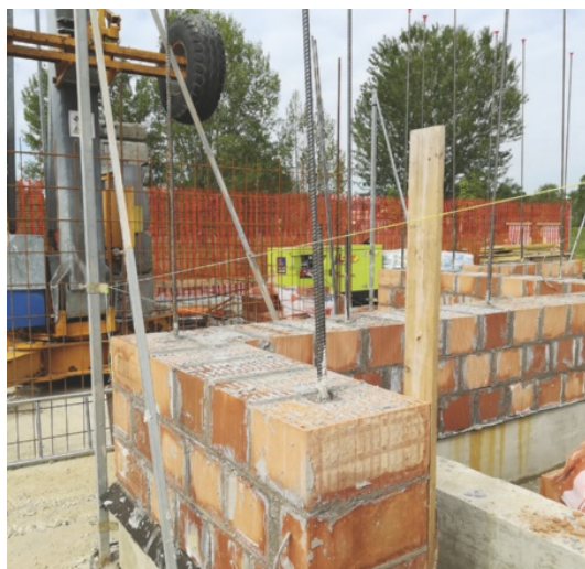
Dettaglio armatura verticale
