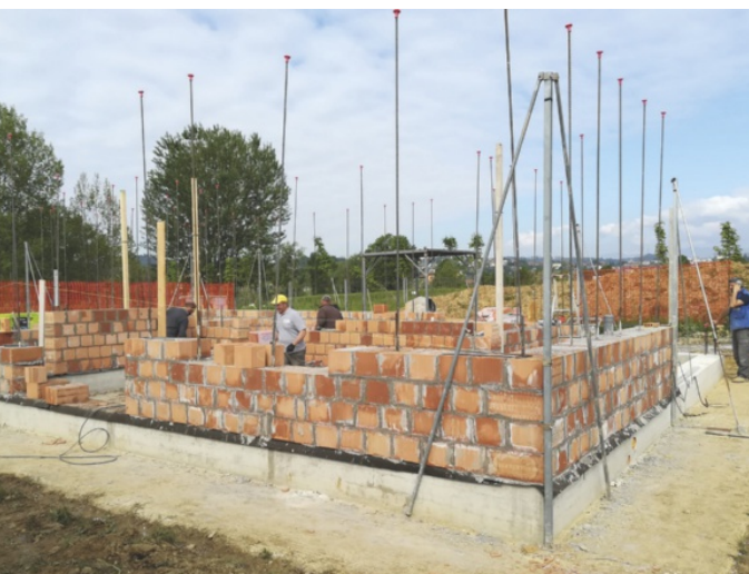
Primi corsi di muratura armata
