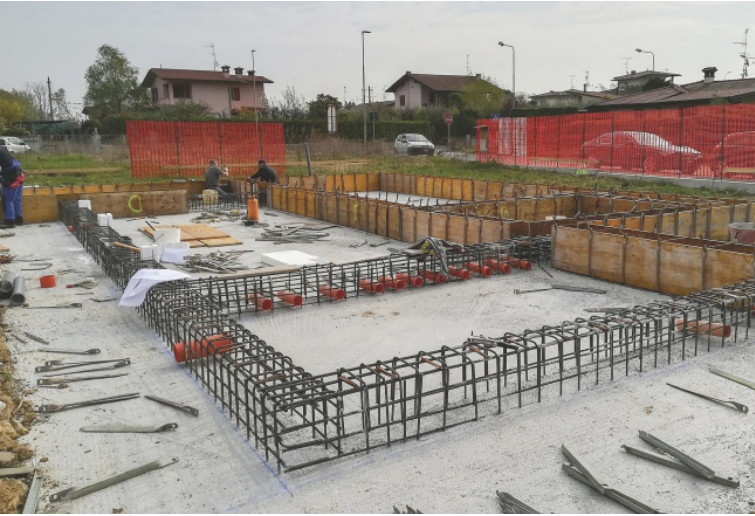
Armatura spiccato di fondazione
