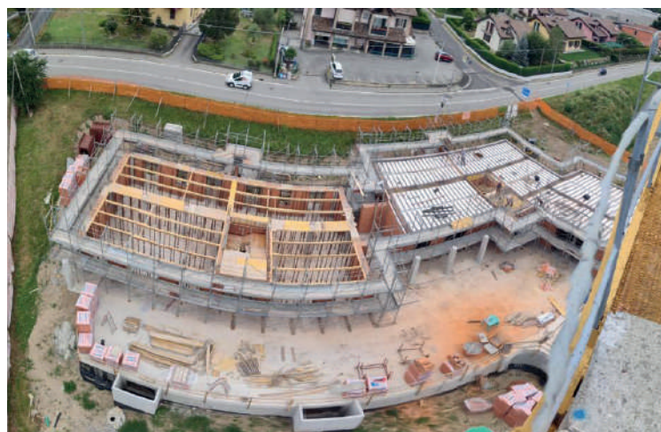
Il sistema Normablok Più realizzato al piano terra.
