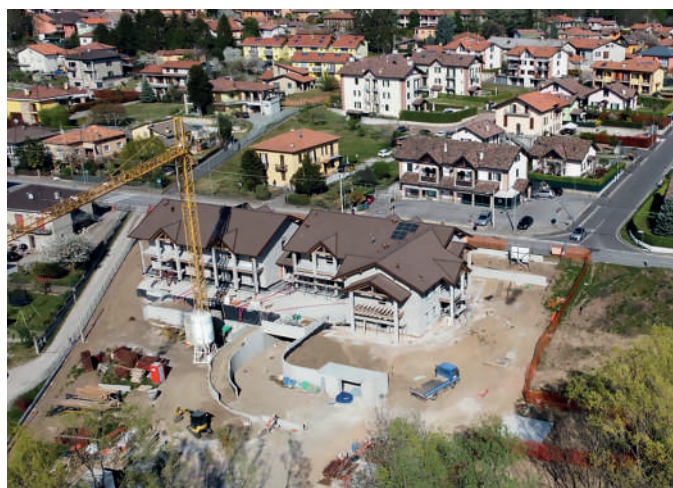
Un'immagine complessiva del cantiere.
