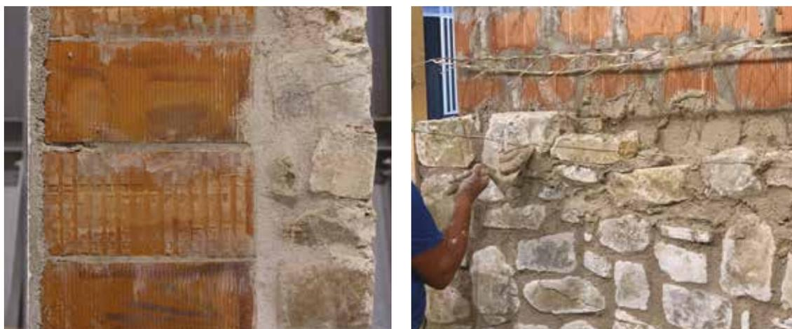
Fig. 1 - La soluzione tecnologica sviluppata per la ricostruzione post-terremoto consiste in una struttura composta dalla muratura armata POROTON® sul lato interno e dalla muratura in pietrame di recupero facciavista esterna opportunamente connesse anche con l'impiego di reti Fibre Net.
